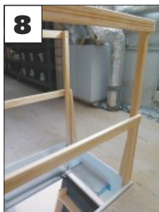
8: Sicherheit: Schutzgeländer. Von der Bauordnung gefordert. In vier Schritten ist die geprüfte Absturzsicherung einfach und stabil montiert.
