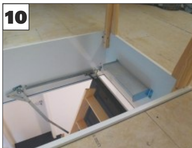
8: Sicherheit: Schutzgeländer. Von der Bauordnung gefordert. In vier Schritten ist die geprüfte Absturzsicherung einfach und stabil montiert.
