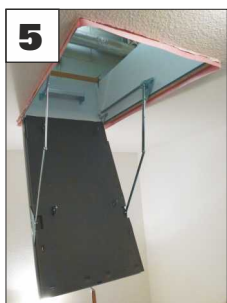
5: Futterkasten in Deckenöffnung einhängen und in der Höhe ausrichten: Waagrecht und bündig mit dem Futterrahmen.
