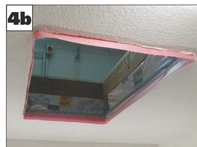
3: Komplettes Einbaumaterial inklusive bauteilgeprüftem Deckenanschluss-System immer dabei: EinbauBox für Wellhöfer WärmeSchutz-Bodentritten.
