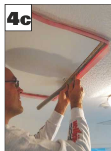
5: Futterkasten in Deckenöffnung einhängen und in der Höhe ausrichten: Waagrecht und bündig mit dem Futterrahmen.
