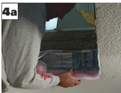
3: Komplettes Einbaumaterial inklusive bauteilgeprüftem Deckenanschluss-System immer dabei: EinbauBox für Wellhöfer WärmeSchutz-Bodentritten.
