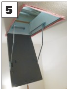
5: Futterkasten in Deckenöffnung einhängen und in der Höhe ausrichten: Waagrecht und bündig mit der Deckenunterkante.
