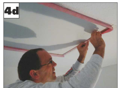
6: Futterkasten mit Justierschrauben im rechten Winkel ausrichten . Fuge zwischen Deckel und Futtersteg muss umlaufend gleich breit sein.
