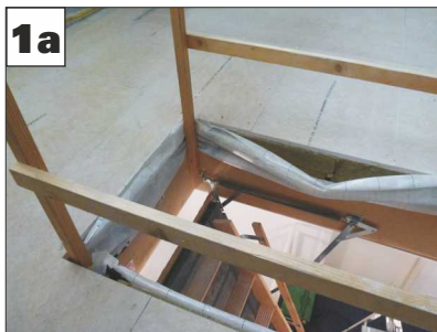
1a: Energetische Sanierung. Dämmung oberste Geschossdecke. Alte Bodentreppe austauschen!
